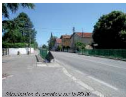
Sécurisation du carrefour sur la RD 86
